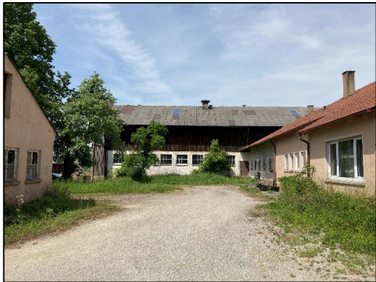
Abbildung 2: Ehemaliges Hofgelände (Stand 19.05.2022)
