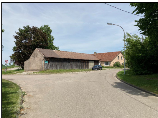
Abbildung 4: Ehemaliges Hofgelände (Stand 19.05.2022)
