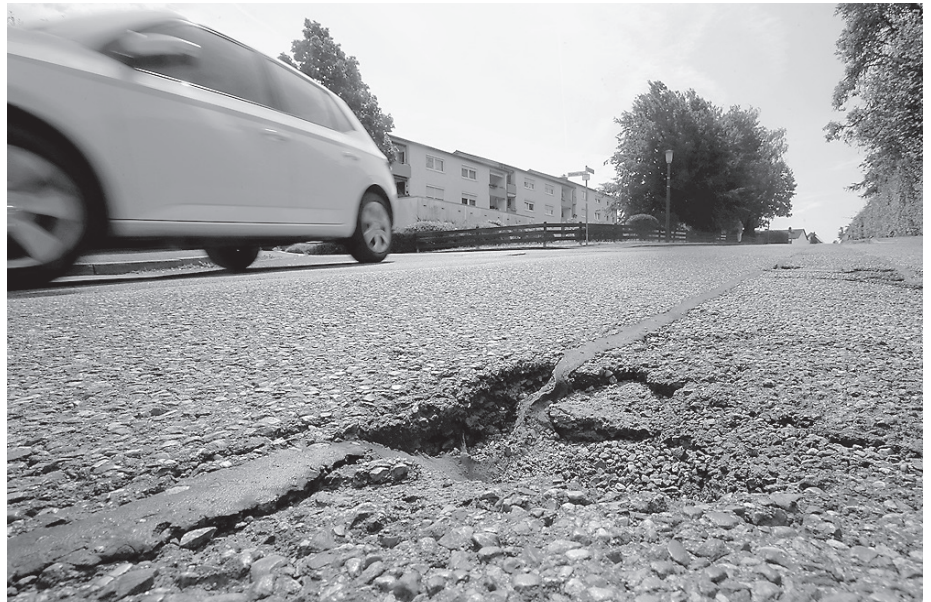
In der Brunnenstraße werden unter anderem Schadstellen beseitigt.
