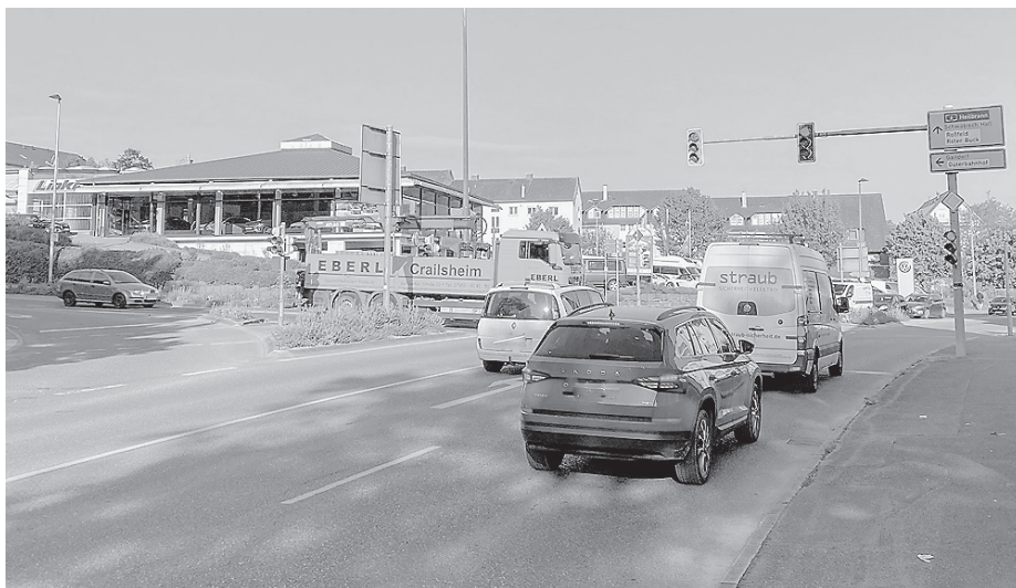
An der Bahnhofskreuzung geht es demnächst los, gearbeitet wird unter Vollsperrung. Fotos: Stadtverwaltung Crailsheim
