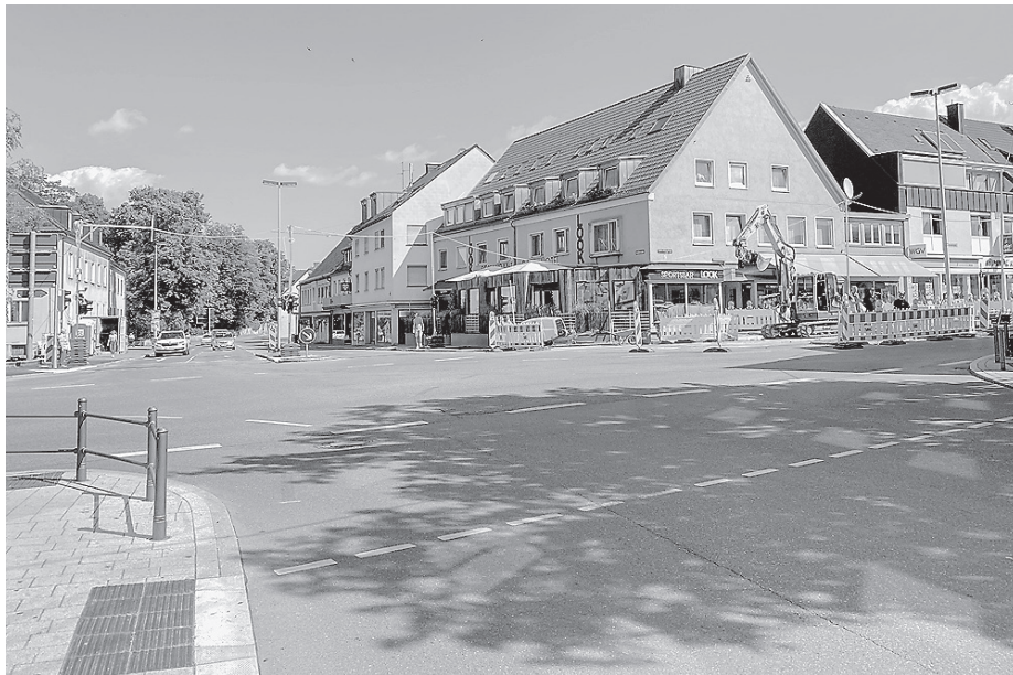
An der Kreuzung am Finanzamt wird aktuell schon längere Zeit gebaut.
